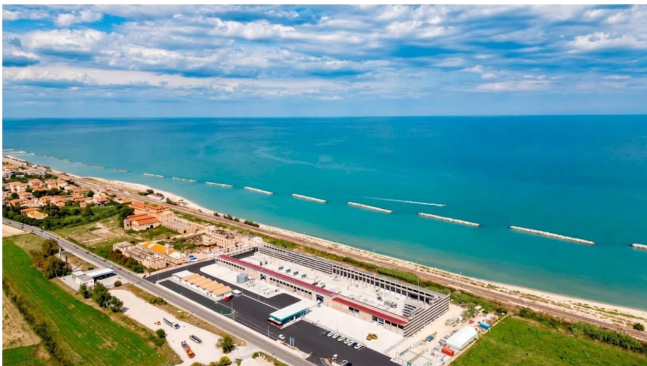
📷 L'area dopo l'intervento
